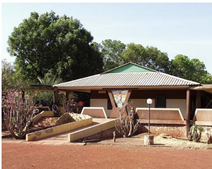
Il reparto attuale di neonatologia/maternità
